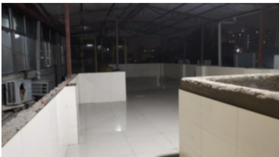
Laboratori di analisi in fase di costruzione
